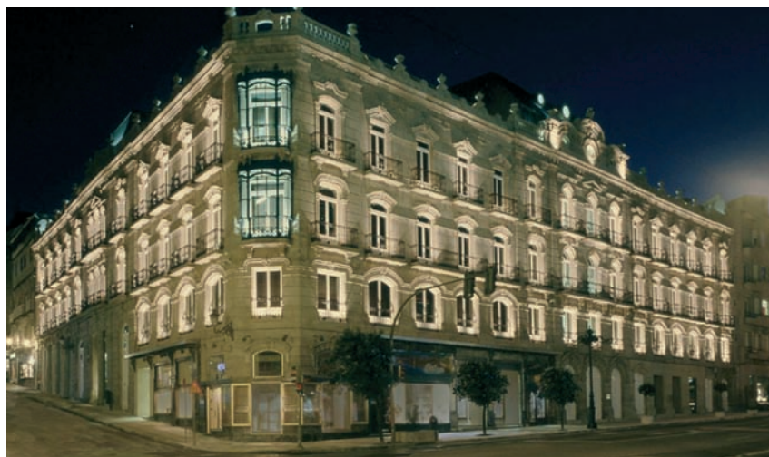
Centro Social de Caixanova
